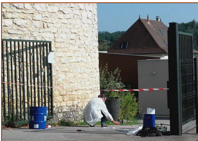
Vérification de l'ancien paratonnerre, emballage pour l'évacuation
